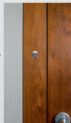
Przycisk do otwierania drzwi umieszczony na pochwycie od strony zewnętrznej (przy przycisku dodatkowa nóżka na pochwycie). Może to być pochwyt okrągły (ø 40 mm) lub prostokątny (profil 40x20 mm)
