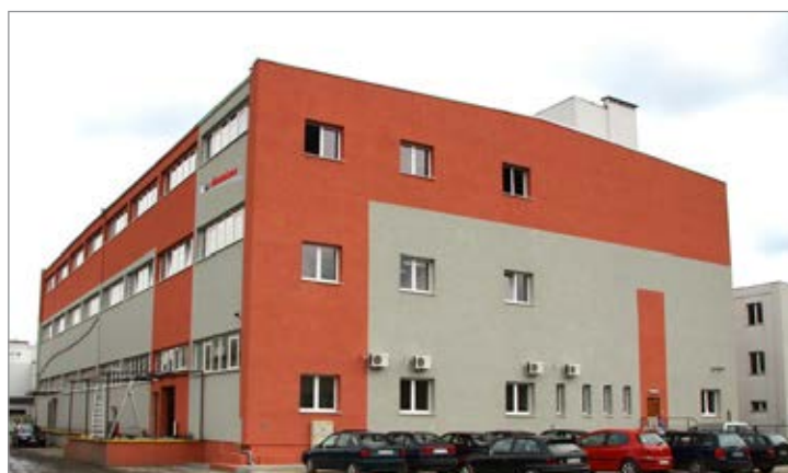
Główny magazyn przy ul. Batalionów Chłopskich
