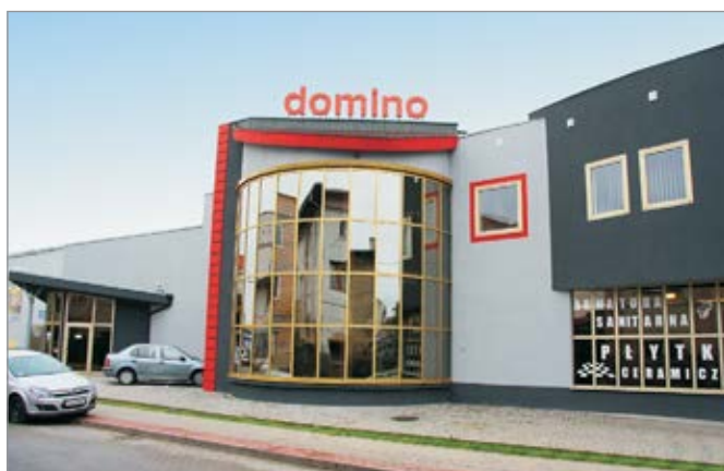
Biuro przy ul. Rzeźniczej
