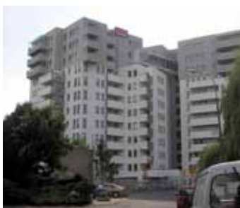
Apartamentowiec „Pelikan”, Poznań
